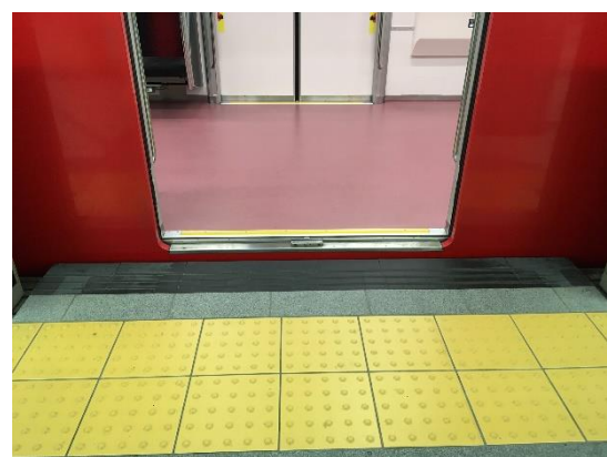
【くし状ゴム整備状況】
