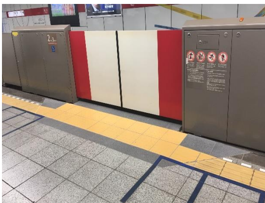
【プラットホームの嵩上げ整備状況】
