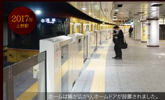
ホームは幅が広がり、ホームドアが設置されました。
