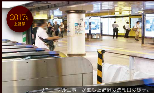
リニューアル工事 が進む上野駅の改札口の様子。
