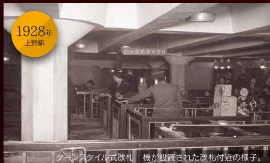
ターンスタイル式改札 機が設置された改札付近の様子。
