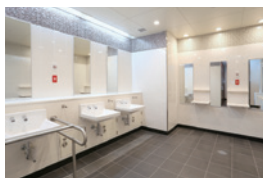
リニューアルされたトイレ(月島駅)
