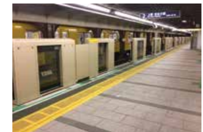
ホームドア設置後のホームの状況
