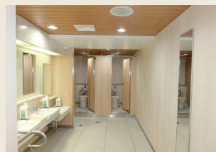
トイレの改装(日比谷駅)
