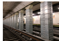
トンネル中柱補強
