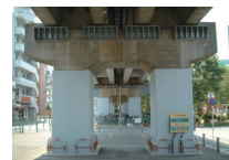
高架橋耐震補強（落橋防止、柱補強）
