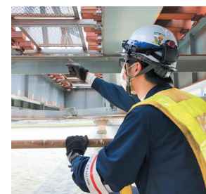
橋りょう検査
