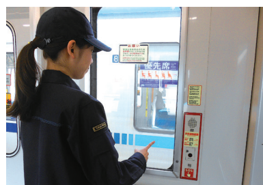
非常通話装置の点検
