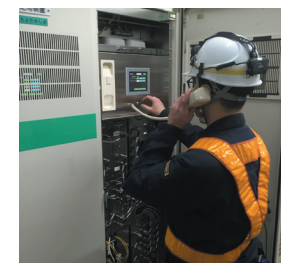
通信設備検査
