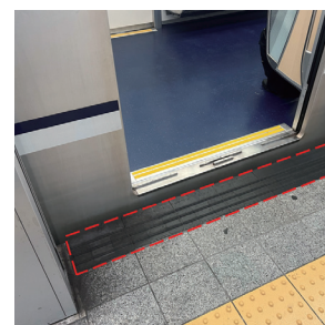
転落防止ゴム (開閉時)
