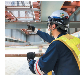
橋りょう検査
