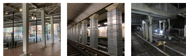
ロッキング橋脚
