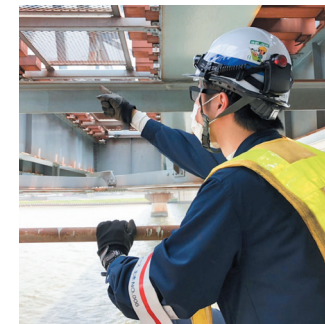
橋りょう検査
