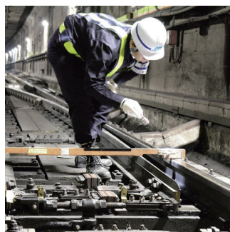
分岐軌道変位検査
