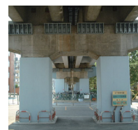
高架橋耐震補強（落橋防止、柱補強）
