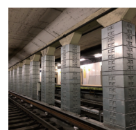
トンネル中柱補強
