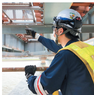
橋りょう検査
