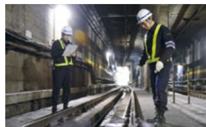
線路点検の様子
